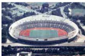
東京オリンピックのメイン会場として改修された国立競技場
